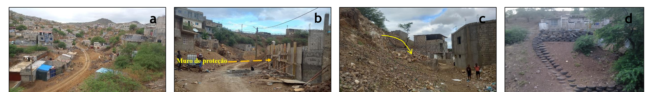
Figura 3. Construção no leito e na margem das ribeiras (a); medidas de ajustamentos a risco de cheias e inundações (b); movimentos de massa em vertentes (c) e medidas de ajustamentos à movimentos de massa (d)
